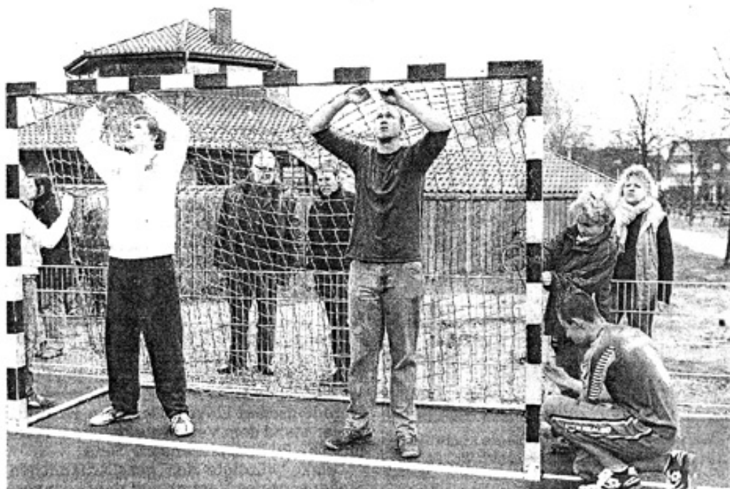
Letzte Arbeiten vor der Einweihung: Die Tore werden eingehängt.
